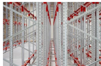
Vista dell'interno del magazzino merci
