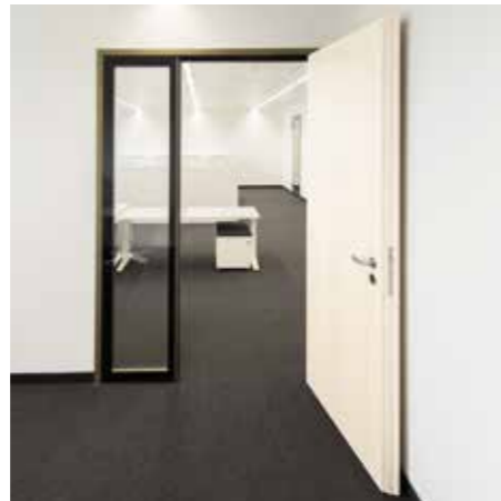
A | Portes en verre composite et éléments avec panneau latéral, huisseries en aluminium éloxé Ouvrage | Immeuble de bureaux, Munich, Allemagne Photos | R. Kuhn, Küffner
