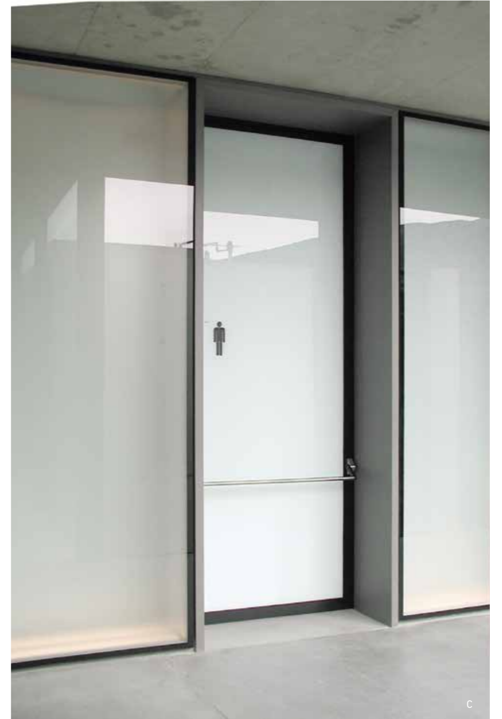
C | Glasverbundtür (GVT) raumhoch, Scheibenzwischenraum satiniert Objekt | Universität, Brixen Fotos | Küffner Aluminiumzargen
