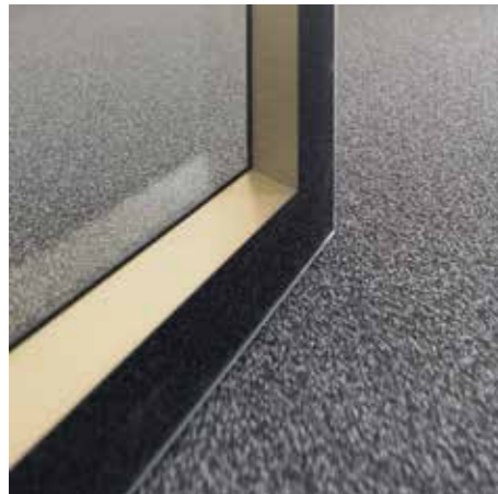
A | Glasverbundtüren und Elemente mit Seitenteil, Aluminiumzargen eloxiert Objekt | Bürogebäude, München Fotos | R. Kuhn, Küffner
